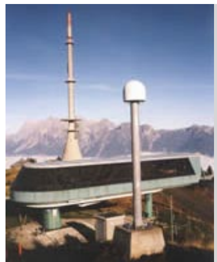
GPS Referenzstation Hauser Kaibling
