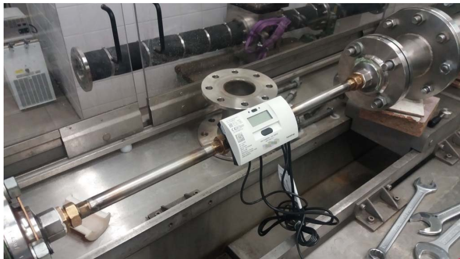
Abbildung 43: Wärmezähler (Foto: Stefan Kuso / BEV)
