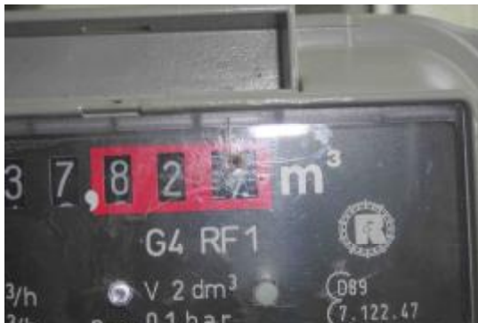
Gebohrtes Loch zur Zählwerksanhaltung
